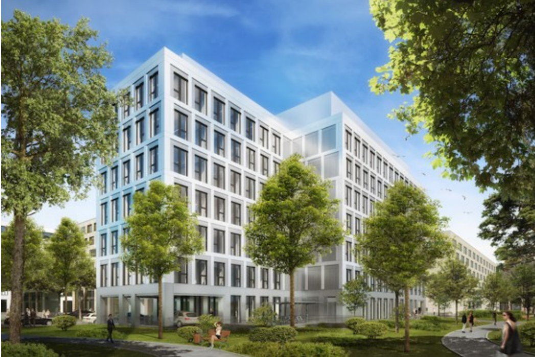
Gateway Gardens: Das „Lindbergh parkside office“ – Ansicht vom Park (Quelle: Groß & Partner/OFB)
